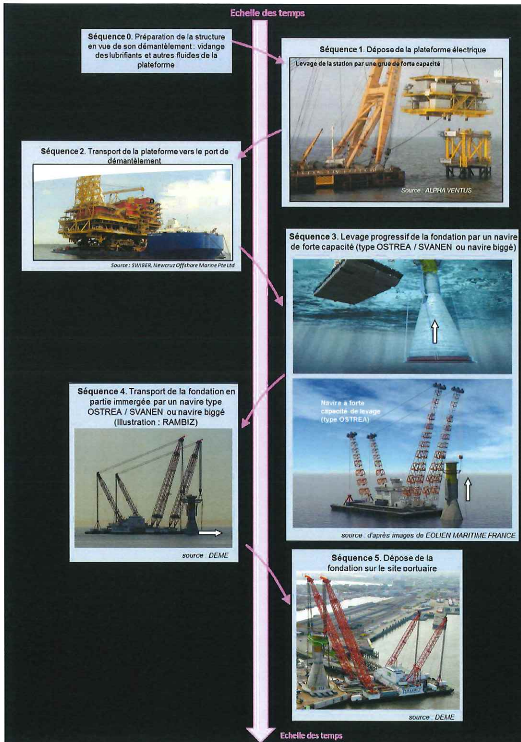
Figure 18 Séquençage des opérations en mer de dépose de la station électrique (plate-forme et fondation gravitaire)
